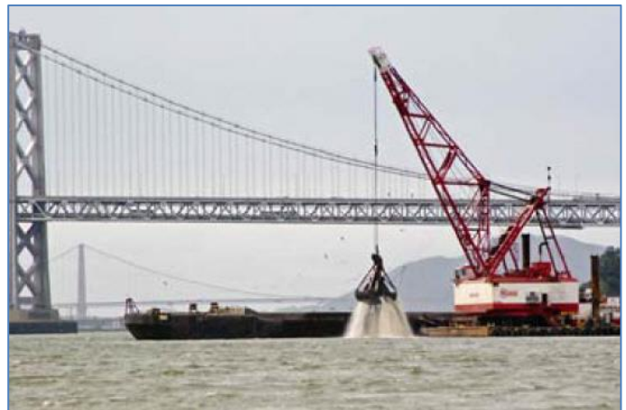
Figure 106 : Curage à l'aide d'une benne preneuse
