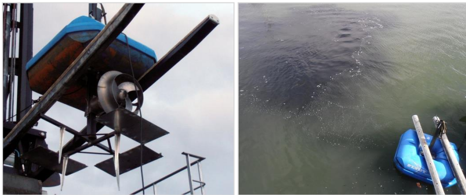
Figure 110 : Système d'agitateur à hélices
